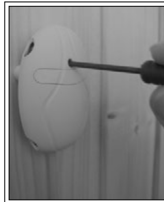
9. ábra: A túlmelegedés-korlátozó Visszaállítás gombja
