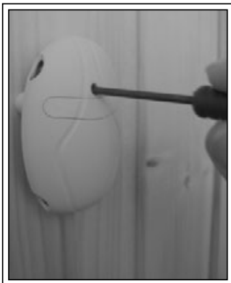
Figure 9. Reset button for overheating limiter Abbildung 9. Rücksetzknopf des Überhitzungsschutzes
